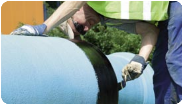
Die Muffenrohre werden gesteckt - die Rohrenden erhalten einen gesonderten Korrosionsschutz
