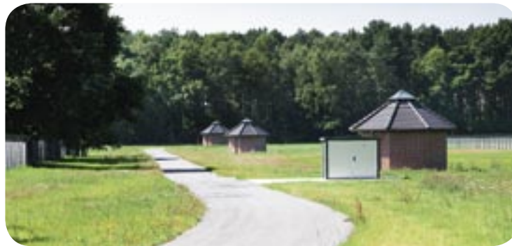
Das neue "Brunnenfeld Süd" im WW Brochterbeck
