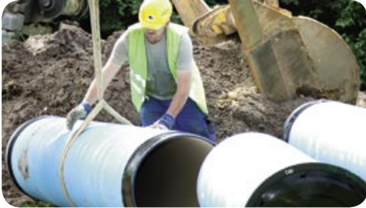
Beim Rohrleitungsbau muss "angepackt" werden
