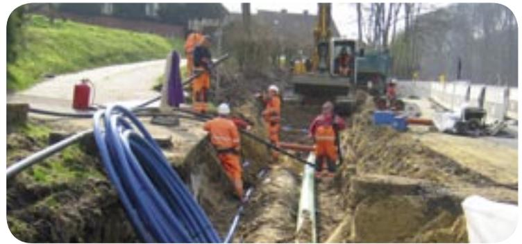
Spart Zeit und Geld: Mehrere Rohre in einem Rohrgraben
