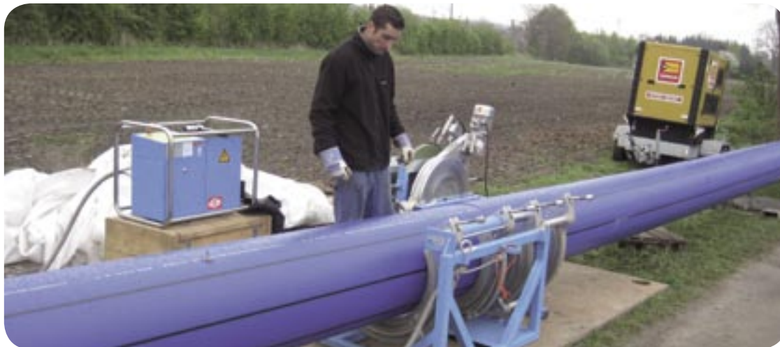
Hier werden zwei Rohre zu einer Leitung "verschweißt"
