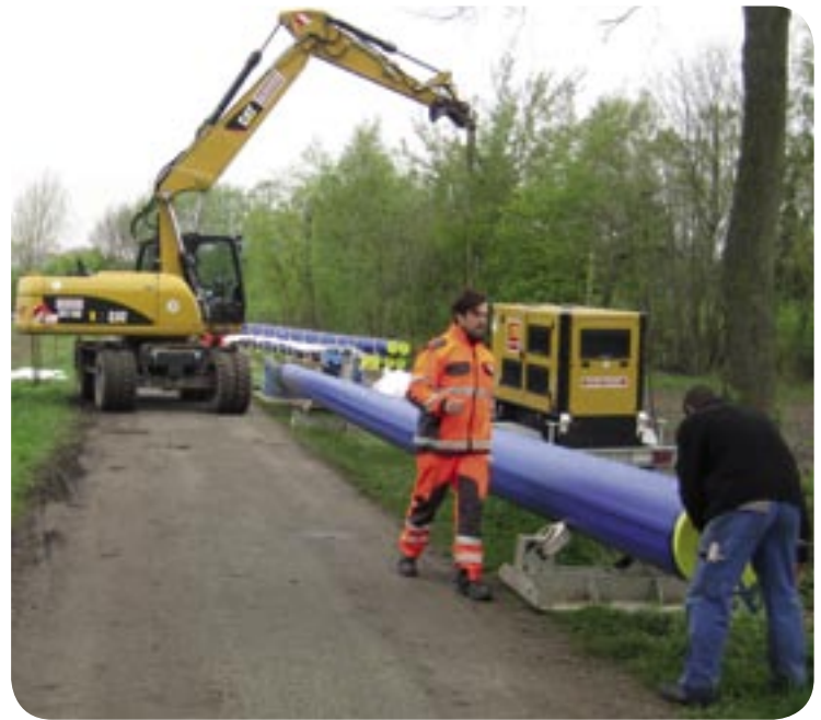
Handarbeit und schweres Gerät sind beim Leitungsbau gefragt!
