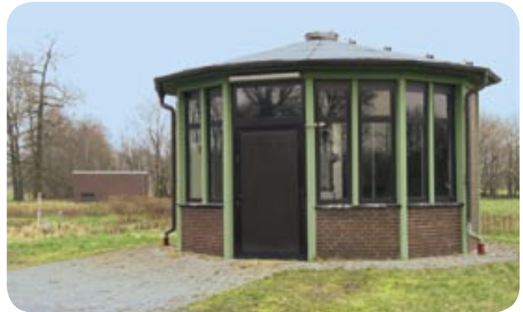
In die Jahre gekommen - Brunnenhäuschen eines Horizontalfilterbrunnens
